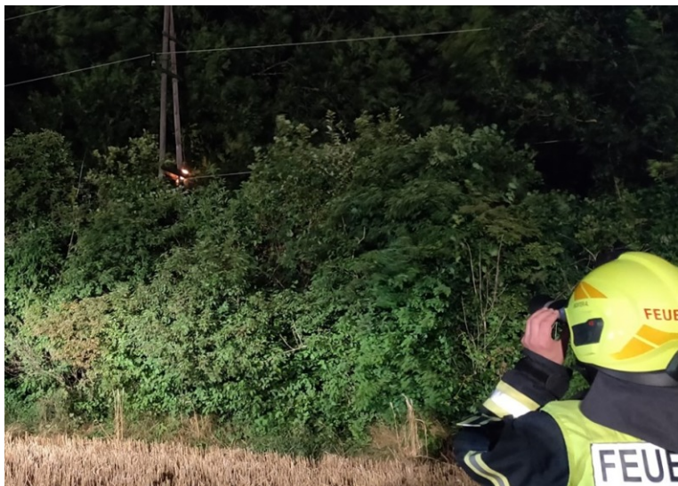
Mittels Wärmebildkamera wurde der Brandherd beobachtet.
